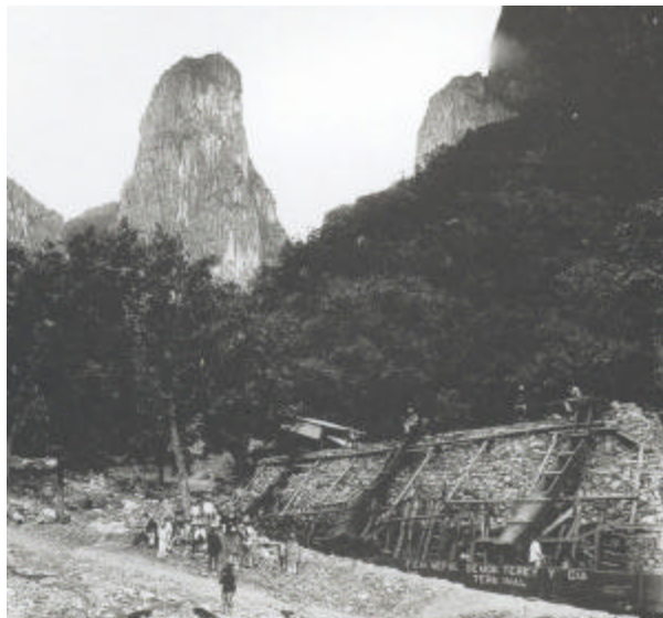
Foto 7. Terminal del ferrocarril en las instalaciones mineras de "El Diente", Monterrey. México.
