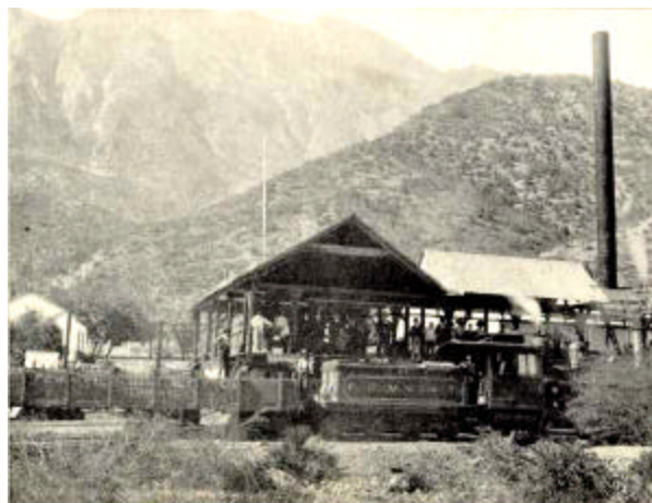
Foto 1. Estación terminal del cable transportador de metales en las Minas de San Pedro.
