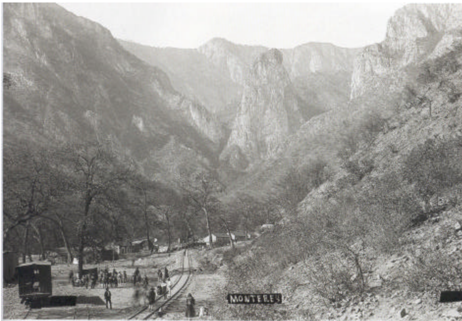
Foto 5. Entrada a las minas ubicadas en la zona de "El Diente", Monterrey, México.
