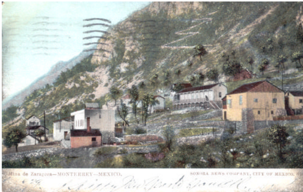
Foto 6. Instalaciones de la Mina de Zaragoza, Monterrey. México.
