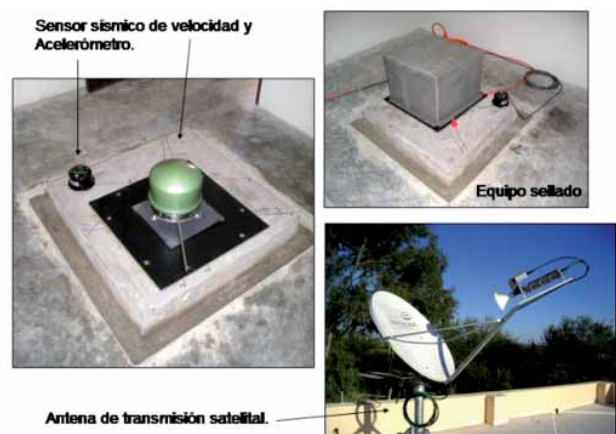
Fig. 9. Equipo sismológico instalado y antena de comunicación satelital de la LNIG.
