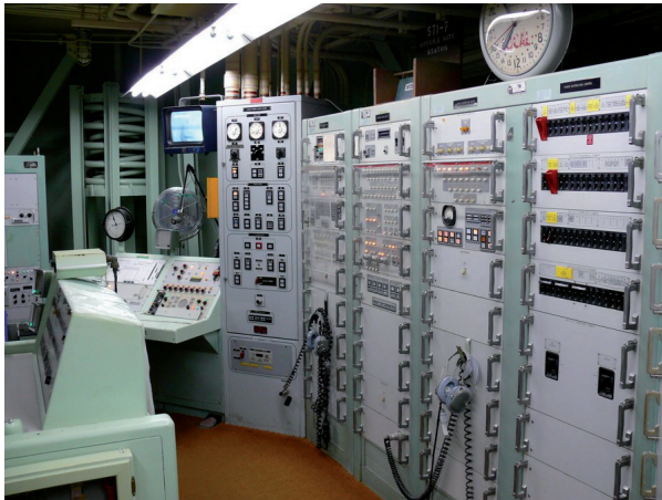
Fotografía 6. La computadora que controla el lanzamiento. Se requieren dos llaves y una clave para que se produzca el inicio del lanzamiento. Este inicio consiste en la liberación del combustible para que empiece a mezclarse con el material oxidante y se inicie la combustión para la propulsión del misil y su lanzamiento.
