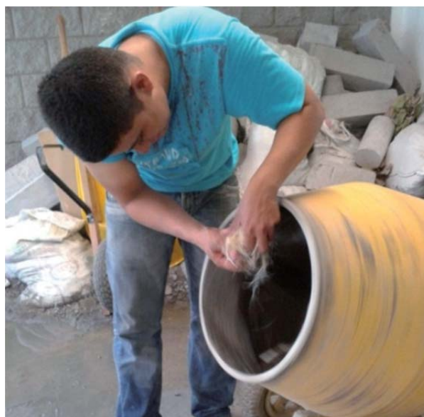
Fig. 3. Mezcla del concreto y adición de fibra de fique.
