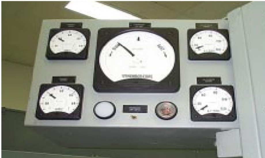
Fig. 4. Ménsula de sincronismo completa.
