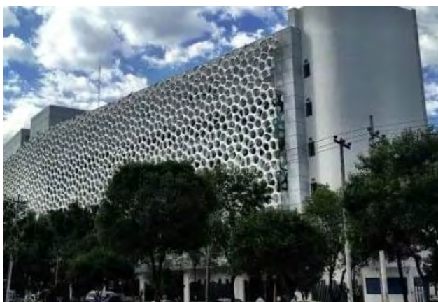
Fig. 4. Primer edificio fotocatalítico en México. 16
